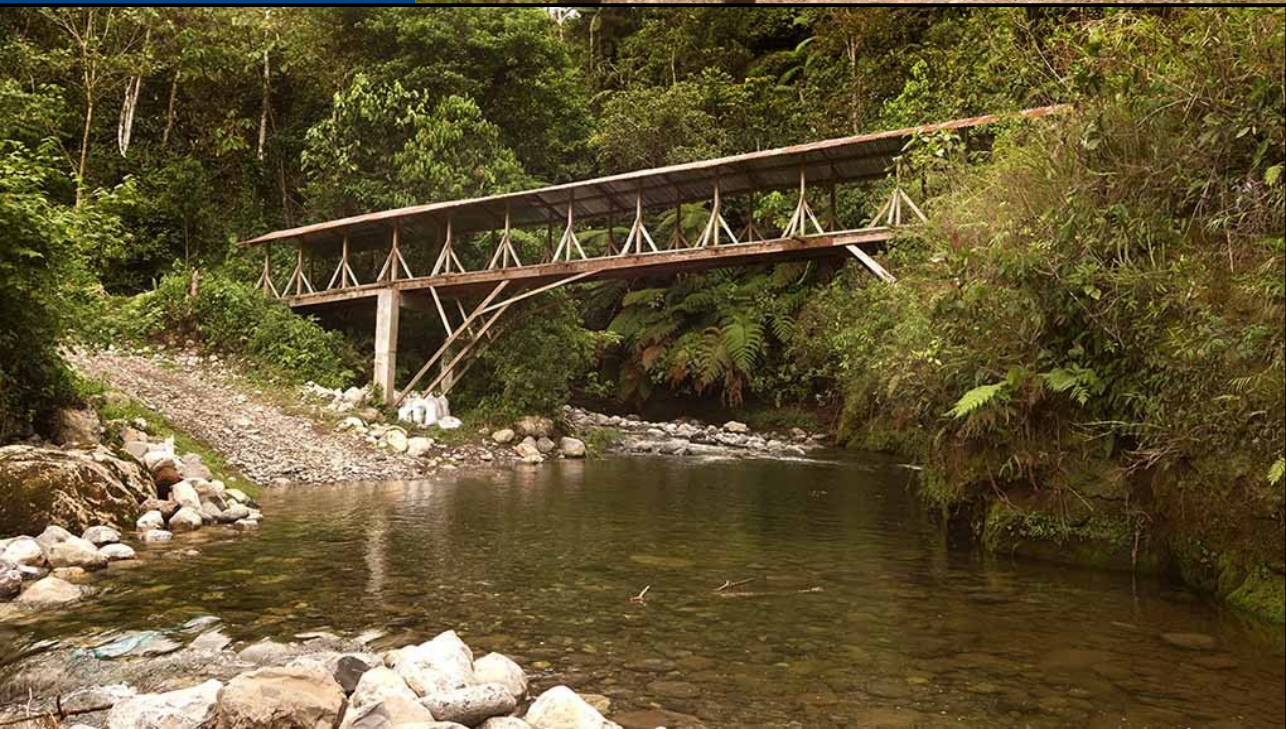
Pont sur le Rio Salas.
