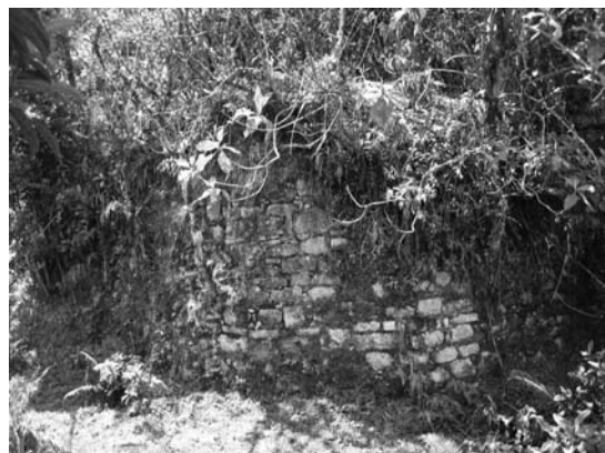
Figura 7 – Mampostería de un edificio, Chaquil (según O. Fabre)
