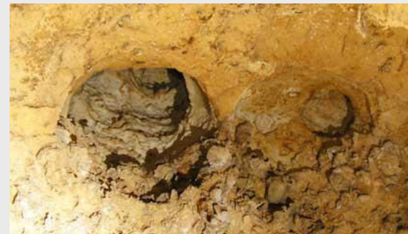
Corrosion différentielle dans les coupoles de la baume des Anges (Donzère, Drôme)
