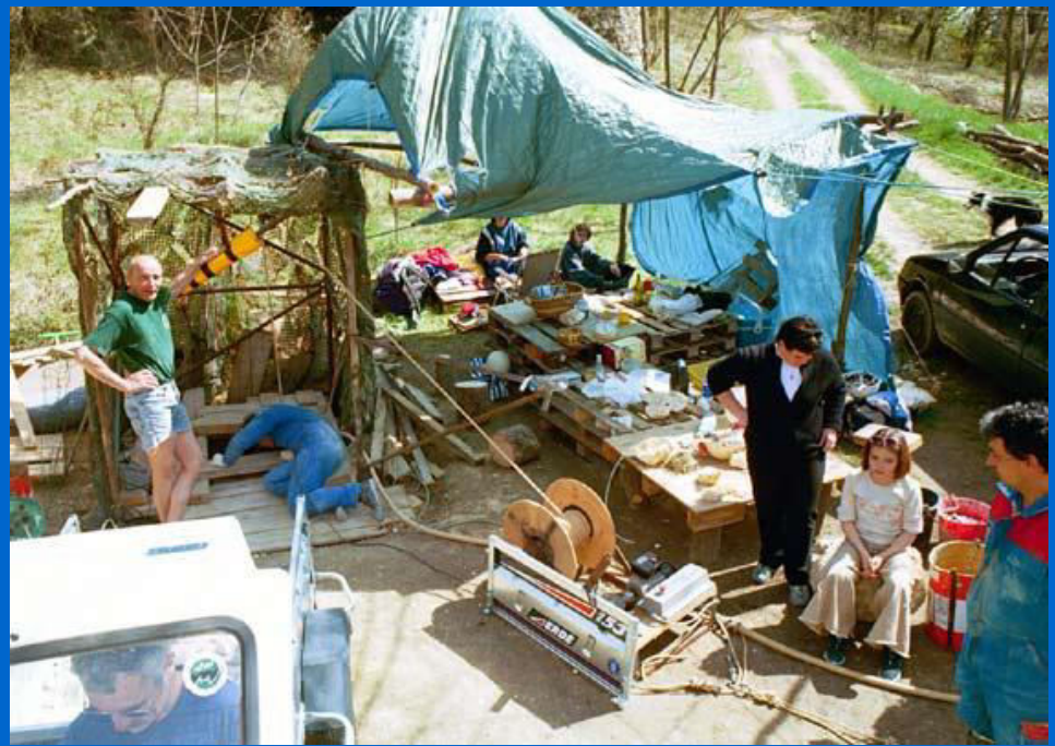
Chantier sur le forage n° 2 de Javelas.
