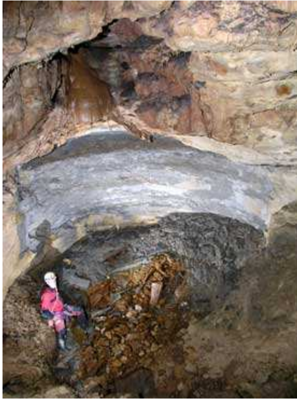
Figure 4 : Strate marneuse intercalée dans les calcaires.
