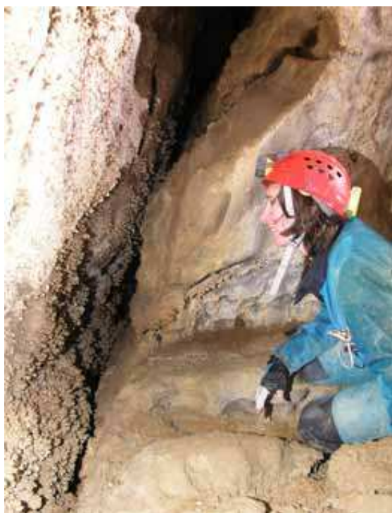
Figure 7 : Concentration de concrétions en choux-fleurs au droit de la fissure.
