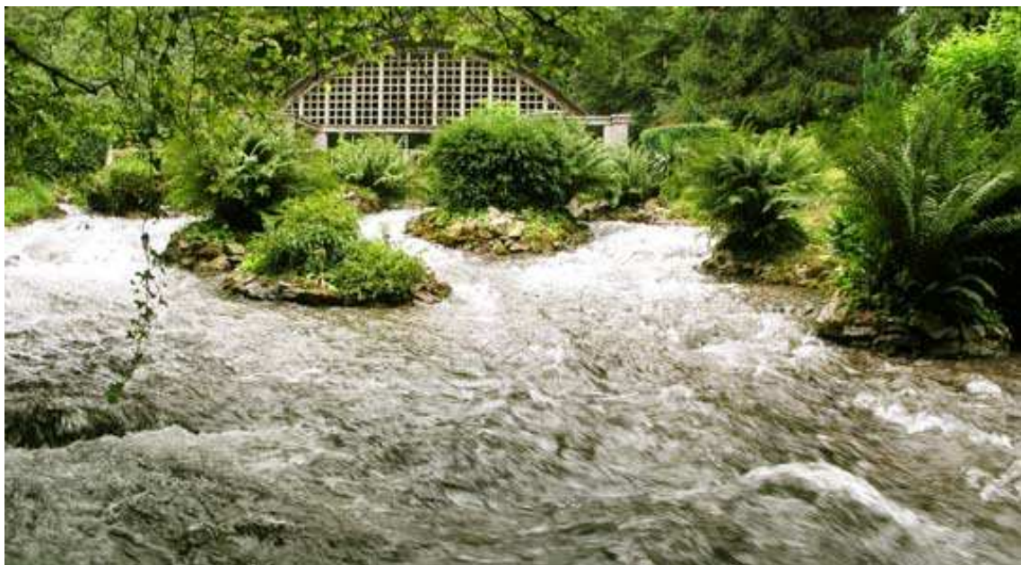
Figure 4 : La station de captage de l'œil du Néez à Rébénacq.
