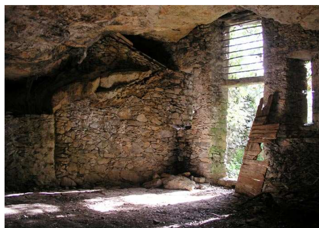
Fig. 9 : Deux ouvertures latérales assurent la ventilation de l'étable.
