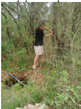
Equipement du puits
