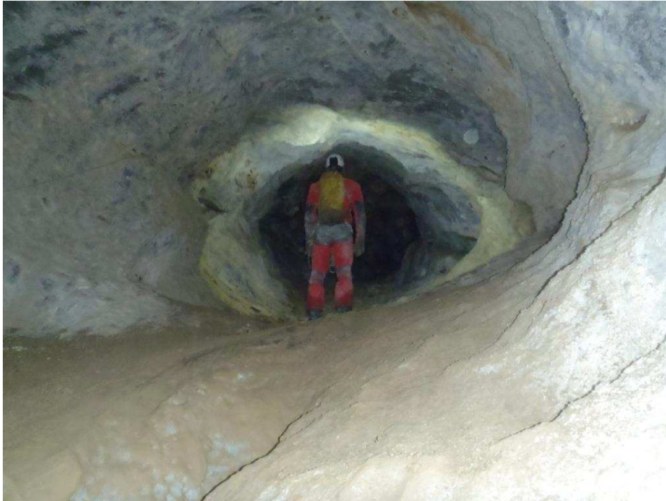
Conduite Forcée à - 200 m
