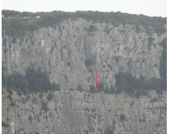
Entrée de la Grotte avec le parking au-dessus – Photo D. Brillant
