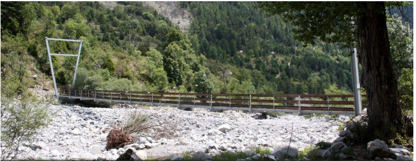
Pont suspendu au-dessus du Coulomp - Photo Google Maps
