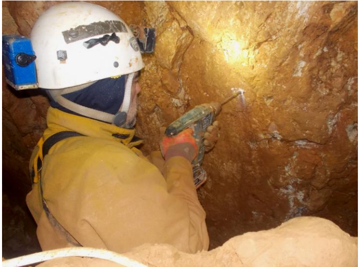
Pose de spit pour 1 autre tronçon de descente sécurisée.
