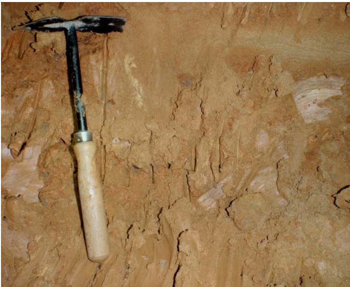
Détail du dépôt qui obstrue le boyau(JS)
