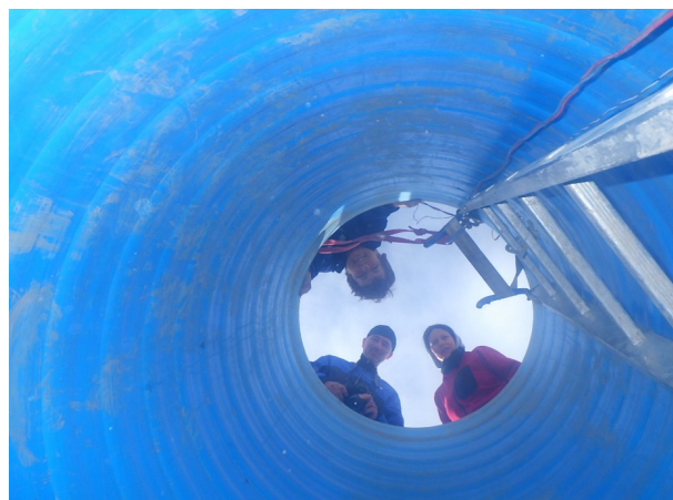
Dans la buse d'entrée (AC).
