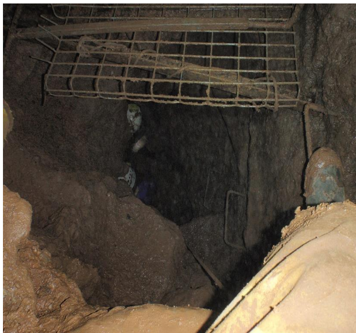
Petit ressaut de 6/7m bien étayé qui mène au fond avec petite plateforme pour poser le matériel de désobstruction(JS)
