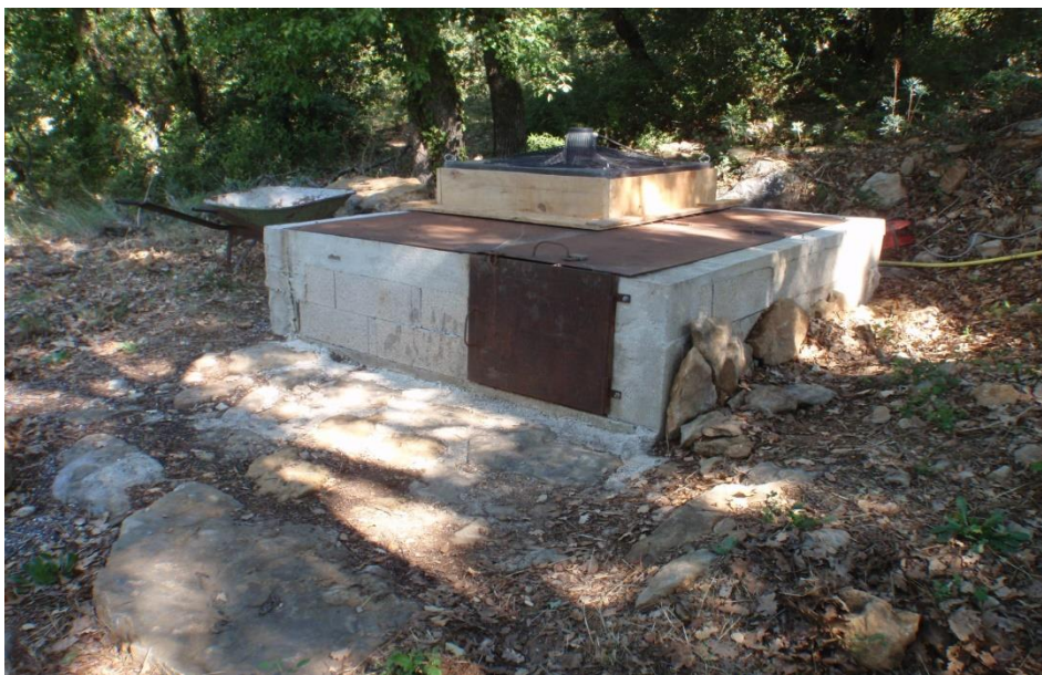
Entrée de l'Aven des Mathieux bâtie avec l'énorme ventilateur qui pulse l'air bien oxygéné(JS)
