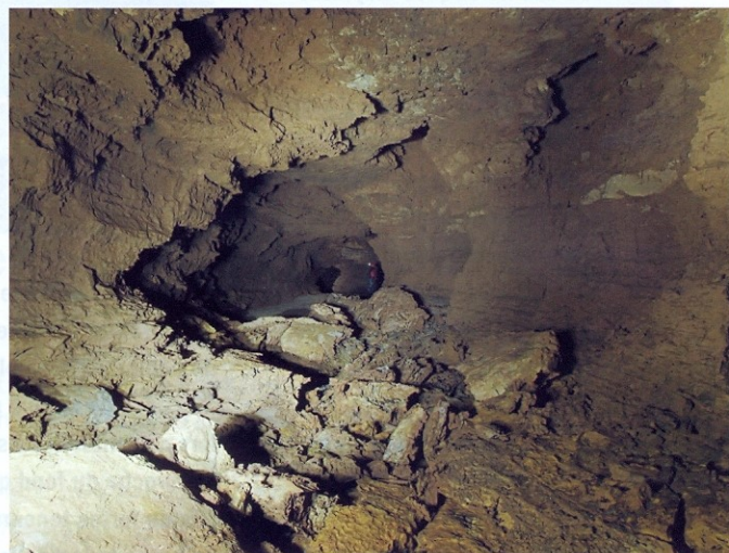
Section aval de la galerie du km cévenol.
