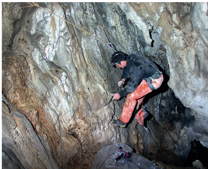
Figure 10: Installation de la main courante et des fers à béton. Les formes en U sont ancrées dans la roche et dominent l'escalier ainsi préservé du piétinement.
